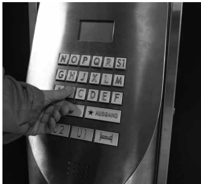
Bedientableau Inselspital Bern: Die Stockwerke sind mit Buchstaben bezeichnet Foto: Fachstelle
