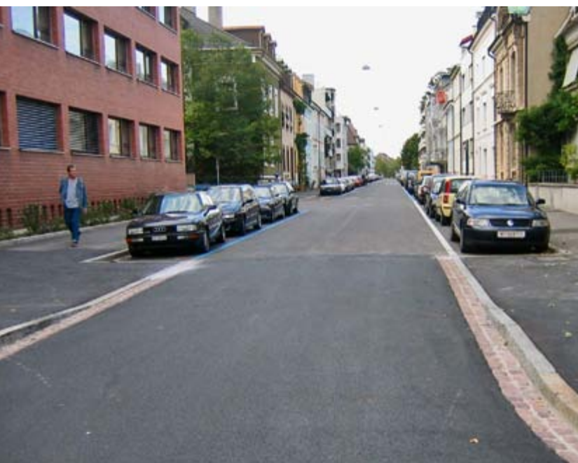
8: Aufgrund der Längsparkierung kann hier nicht flächig gequert werden. Eine Querungsstelle ist im Einmündungsbereich ausgebildet. (Basel, Tempo-30-Zone)
