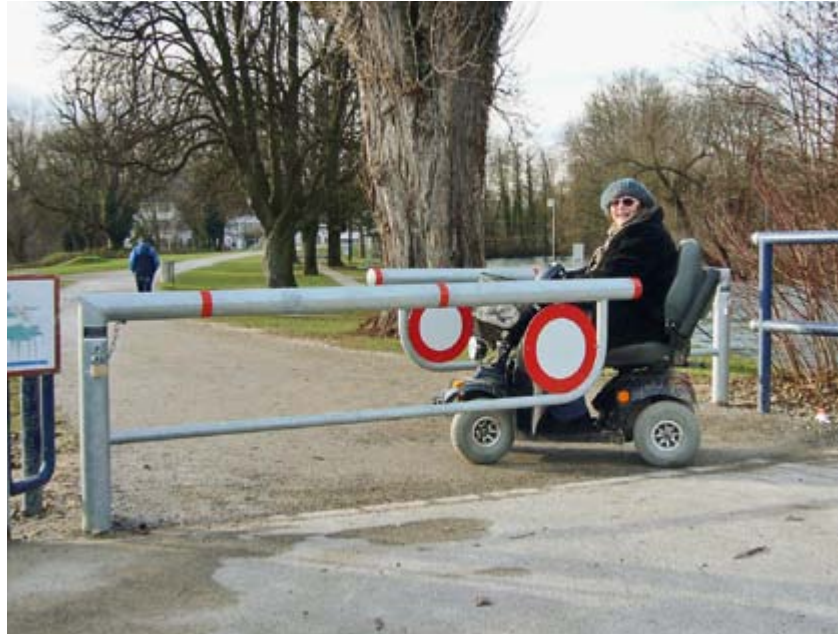
2: Schikanen müssen die Durchfahrt mit Fahrhilfen für den Aussenraum gewährleisten. (Bild: Zürich, Werdinsel)
