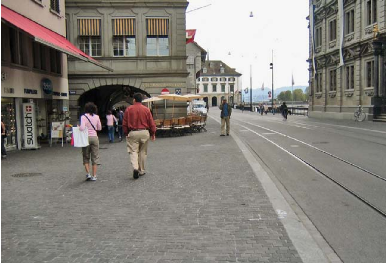
6: Ein 3 cm hoher Randabschluss sowie ein Belagswechsel machen die Fahrbahn mit Tramlinie deutlich ertastbar. (Bild: Zürich, Limmatquai)
