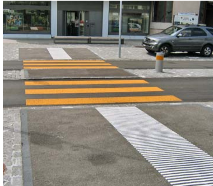
5: Beim Fussgängerstreifen wird aus dem Mehrzweckstreifen eine Mittelinsel mit ertastbaren Randabschlüssen. Da die ganze Ortsdurchfahrt nur 3 cm hohe Randabschlüsse aufweist, gibt es keine erkennbaren Absenkungen und die Querungsstelle muss mit taktil-visuellen Markierungen gekennzeichnet werden. Dazu musste die sehr unebene Pflasterung durch eine Asphaltfläche ersetzt werden. (Bild: Birmensdorf)
