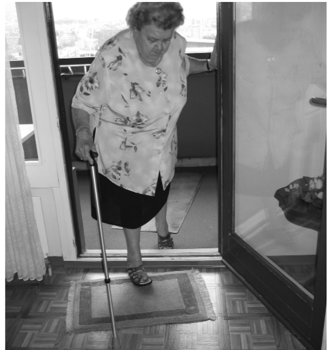
Hohe Balkontürschwellen erschweren das Benutzen des Balkons.
