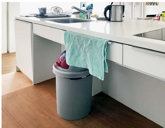
Die Elemente unter Herd und Spülbecken wurden entfernt und der Boden mithilfe eines Podests erhöht.
