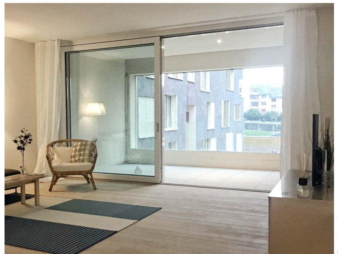
Ohne Stufen und Schwellen sind alle Wohnbereiche, auch Balkon oder Terrasse, hindernisfrei zugänglich.
