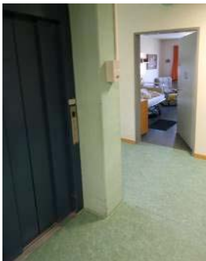
An dieser Ecke kommt es laut Heimleiter immer wieder zu Unfällen, weil Bewohner wegen mangelndem Kontrast Vordergrund und Hintergrund nicht unterscheiden können
