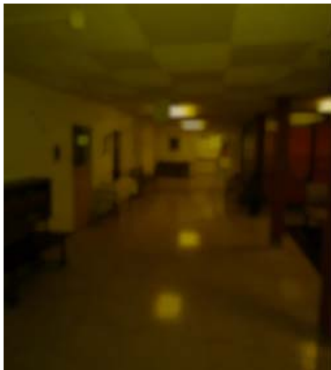
Foyer aus Sicht eines alten Menschen: Ungenügende Beleuchtungsstärke, erschwerte Orientierung, störende Spiegelungen die sich beim Gehen bewegen und ins- besondere Personen mit Demenz verwirren.
