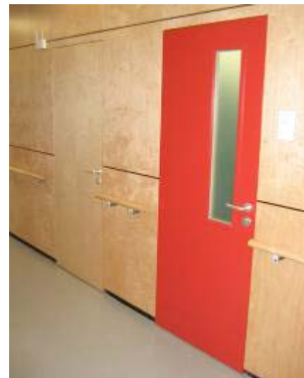
In Demenzabteilungen werden Türen zu Personal- oder Serviceräumen (links) bewusst kontrastarm, Türen zu Bewohnerzimmern oder WCs (rechts) dagegen auffällig gestaltet
