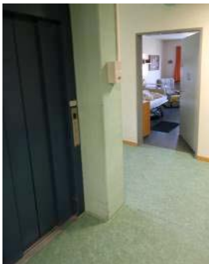
An dieser Ecke kommt es laut Heimleiter immer wieder zu Unfällen, weil Bewohner wegen mangelndem Kontrast Vordergrund und Hintergrund nicht unterscheiden können
