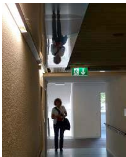
Trugbild an der Decke im Flur eines Pflegeheimes
