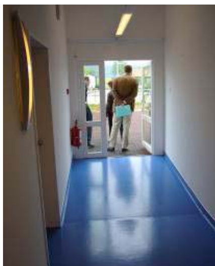
Spiegelnder Bodenbelag in einer Demenzabteilung
