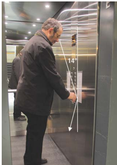
Bild 10: Das Licht wird zum Boden reflektiert. Die Chromstahlfläche wirkt sehr dunkel
