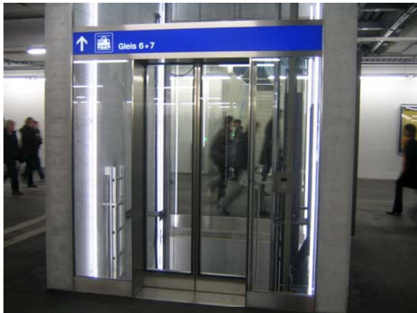
Bild 14: Beleuchtung im Liftschacht als Designelement hat eine starke, Blendwirkung
