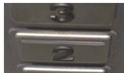
Schwarze Schrift auf Chromstahl ergibt keinen ausreichenden Kontrast
