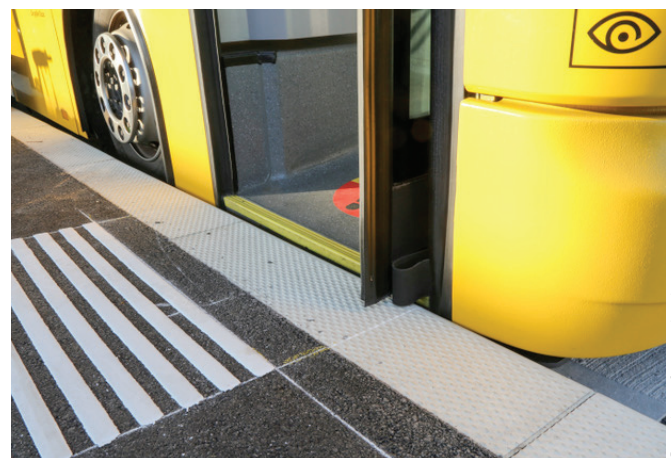
Ein positives Beispiel im Kanton Luzern ist Menznau. Hier wurden bereits 2020 konsequent hohe Haltekanten im Busbahnhof umgesetzt.
